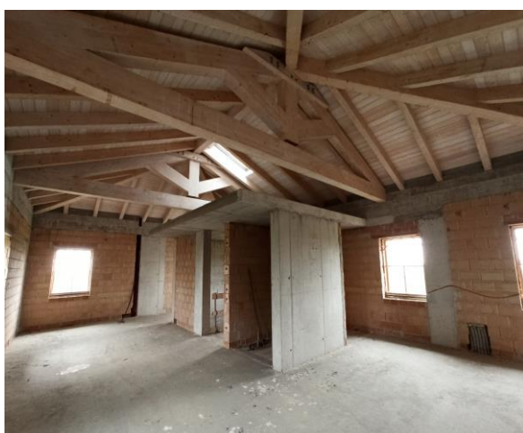
Foto di interni al Piano sottotetto
