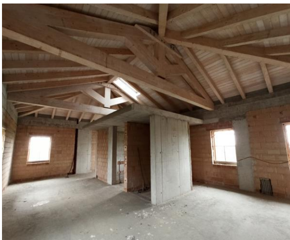
Foto di interni al Piano sottotetto
